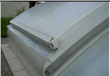
Ne pas oublier de mettre une chute de moquette (ou autre) pour protéger la plaque du module fixe d'en dessous
