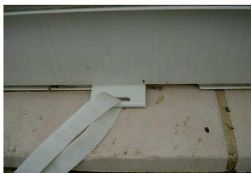
Glisser par l'encoche de pièce du bas la pièce identique au téillon de béquille de levage, et la décaler vers la droite
