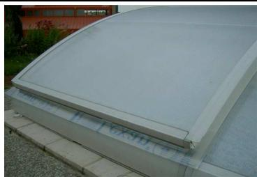
Le superposer sur le dernier module fixe
