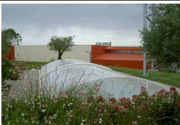
Pour des raisons de sécurité, nous avons décidé de stocker tous les modules sur le dernier module fixe. Ce dernier restera fixé sur les margelles avec ses molettes.
