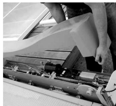
**7.3** Soulever le capot du bloc moteur en prenant garde au câble de la commande à clé
