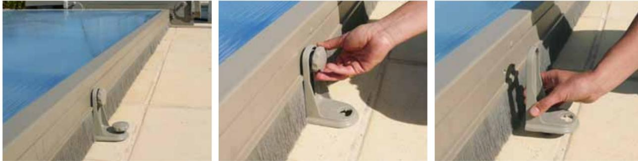
Dévisser les molettes dans le sens inverse des aiguilles d'une montre. Enlever la patte de fixation.
