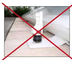
**2-3-** Abaisser le levier pour verrouiller la fixation en maintenant une pression sur la patte de fixation.
