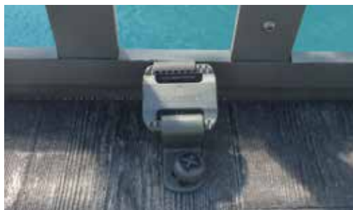
Molettes de fixation au sol
