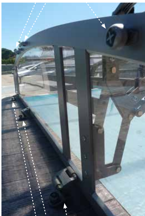
Molettes de fixation au sol de la façade
