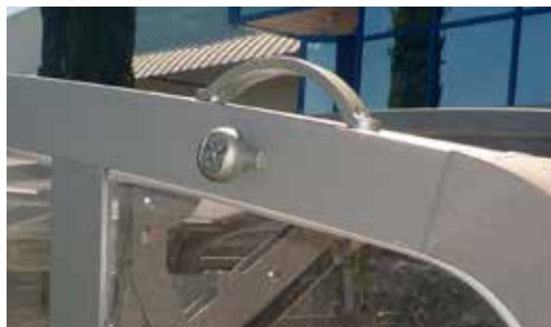
Molettes de fixation du fronton (fond ou façade)
